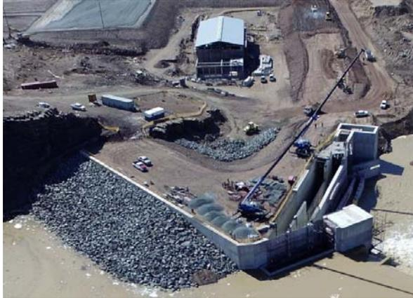
*Fig. 6. Neckartal Dam: Sediment trap.*
