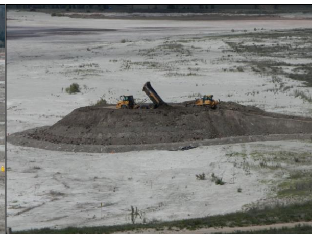
B - Fill Placement
